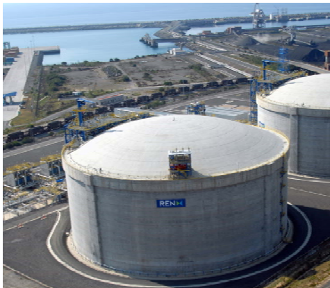
Terminal de GNL
