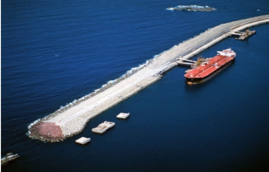
Terminal marítimo de Sines
